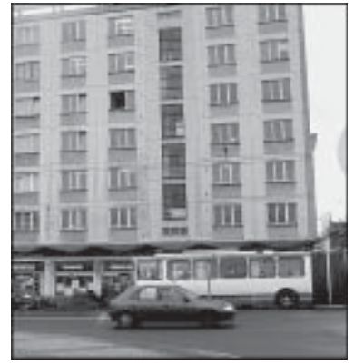
Objekt na Palackého ulici byl řadu let nevyužit. Nyní zde radnice plánuje přestěhování čtyř odborů.
