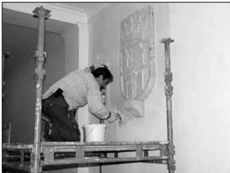
Do vestibulu budovy MěÚ na Husově náměstí znak nainstalovala pracovní skupina města, na snímku při začišťování Pavel Geci. (foto: sk)
