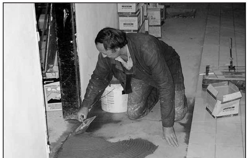
Chodba do centrální stravovny bude mít novou dlažbu. Na snímku při jejím pokládání Miloslav Pochmann. (foto: mk)
